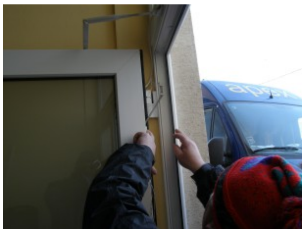
Inštalácia priechodky kabeláže
